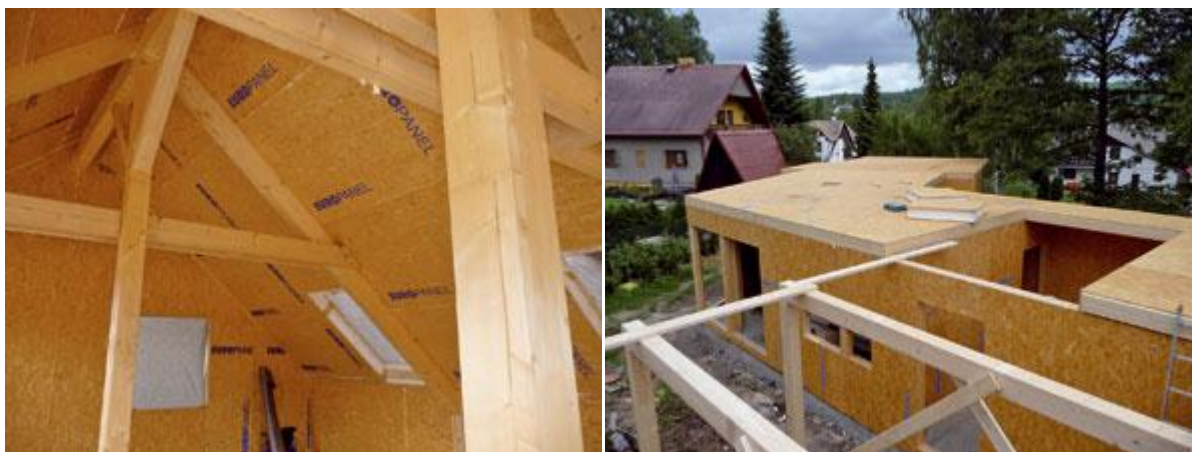
Detail podkrovia hrubej stavby domu s panelovou strechou Použitie panelov SIPs na plášť plochej strechy
